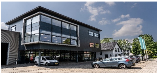
Marconibaan te Nieuwegein, Hoofdvestiging
