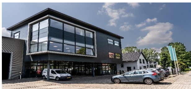
Marconibaan 44 te Nieuwegein, Hoofdvestiging
